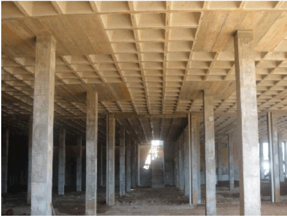
Figura 15 – Exemplo de estrutura não reticulada (laje plana) - (Fonte: ATEX Brasil – SEDE COPAZA - SC)
